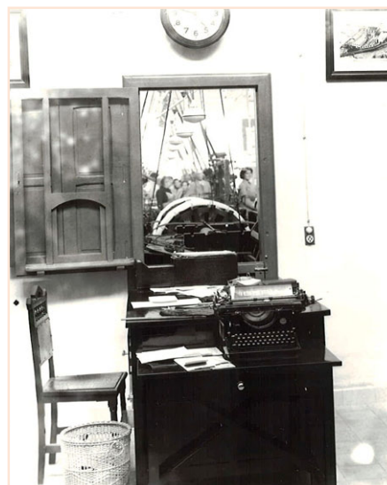
Vista del interior de la fábrica de tejidos Bertrand desde una ventana de las oficinas (1945). Fotografía cedida por el Archivo Municipal de Lorca
