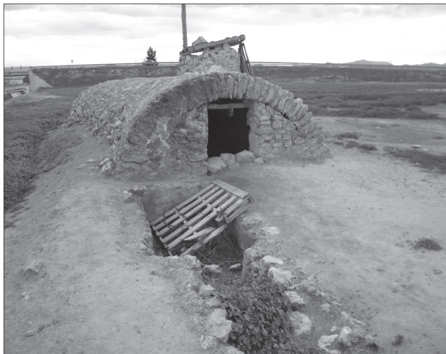
FIGURA 4. El abandono de la población rural ha acarreado también el abandono de las prácticas de conservación de los aljibes y otros sistemas de captación de agua tales como el sistema de boqueras, minas, «lumbreras» y cultivo en cañada. En la imagen, aljibe bastante deteriorado junto a la carretera de Los Almagros y El Escobar a Fuente Álamo.
