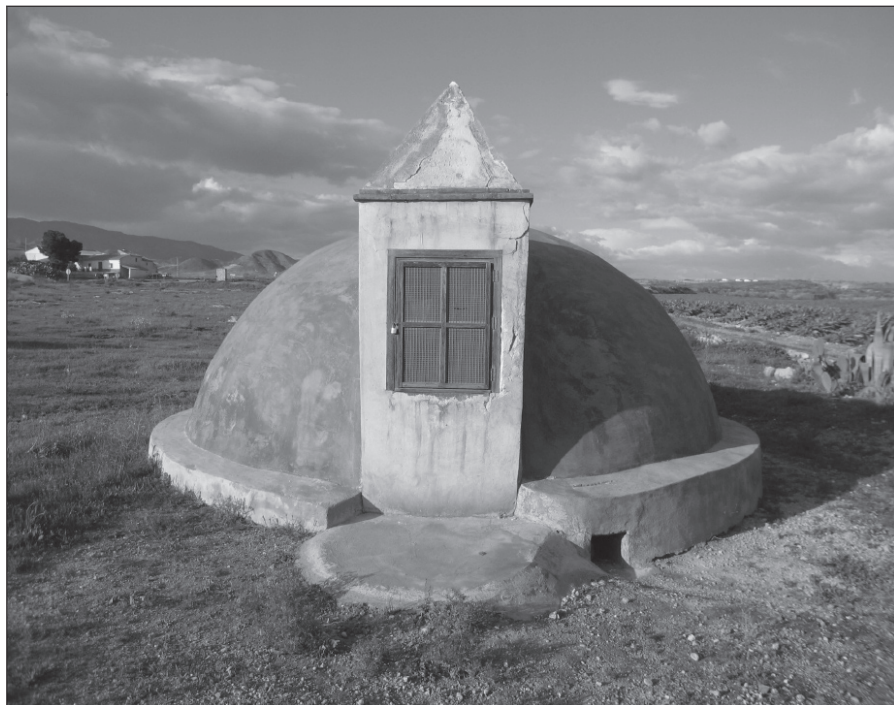
FIGURA 2. Los aljibes del Campo de Cartagena ofrecen variada arquitectura. Las más frecuentes son en cúpula y en bóveda. La imagen, muestra uno del primer tipo restaurado y localizado en El Escobar.
