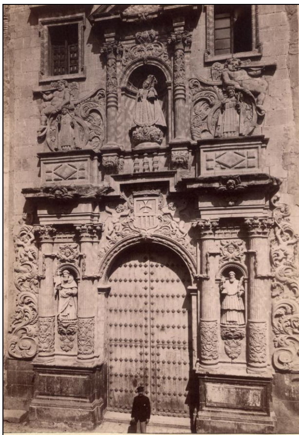
Figura 47: Fachada de la iglesia de La Merced (Murcia): 1905 –1907.
