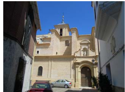
Vista de la fachada sur con la hornacina sobre la puerta.
