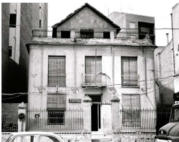
Figura 24. Edificio de Correos. Inmueble desaparecido a lo largo del siglo XX. Fuente: archivo.molinasegura.es .
