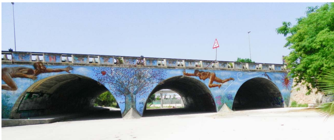
Figura 48. Puente de la rambla de los Calderones. Fuente: Elaboración propia.
