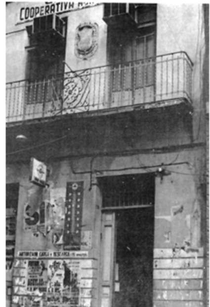
Fachada de la Casa Tercia, con el escudo en el cuerpo superior.
