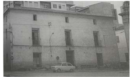
Fachada de la casa parroquial.
