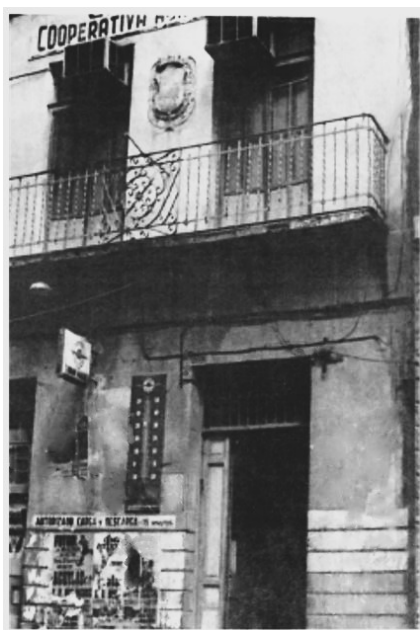
Figura 30. Fachada de la Casa Tercia, propiedad de la Cooperativa Agrícola de Molina. Fuente: (Reyes, 1979, p. 23).
