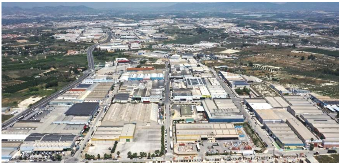
Figura 59. Polígono industrial El Tapiado. Nuevas localizaciones para la industria local alejadas del espacio urbano. Fuente: Murcia Plaza.
