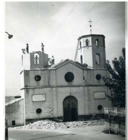
Ermita durante el proceso de derribo.
