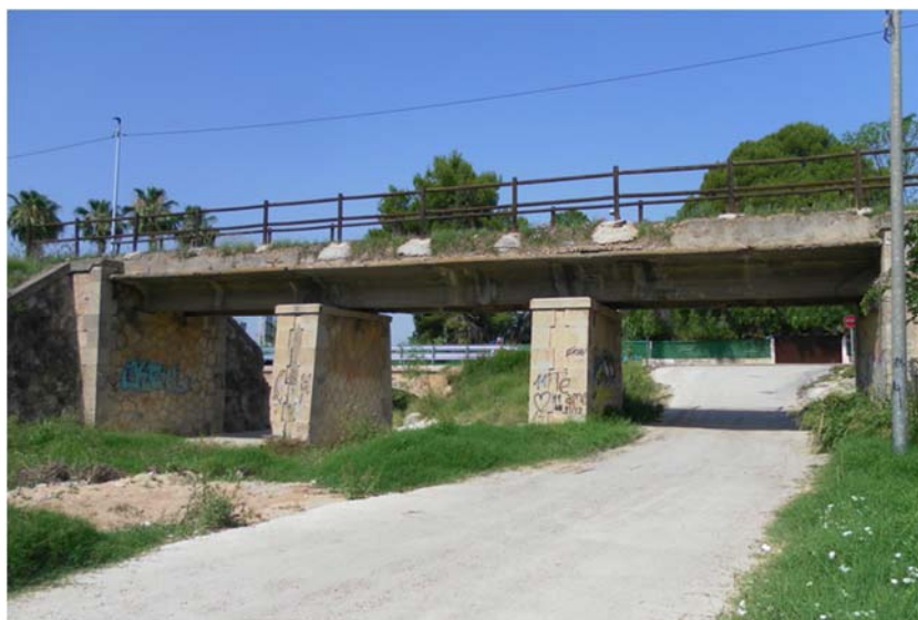
Figura 51. Puente de la antigua línea de ferrocarril Murcia-Caravaca en la rambla de los Calderones. Fuente: Elaboración propia.
