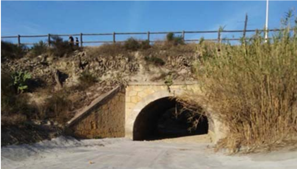
Figura 52. Túnel en la Ribera de Molina, parte del trazado de la vía Verde del NO. Activo sin catalogar. Fuente: Elaboración propia.
