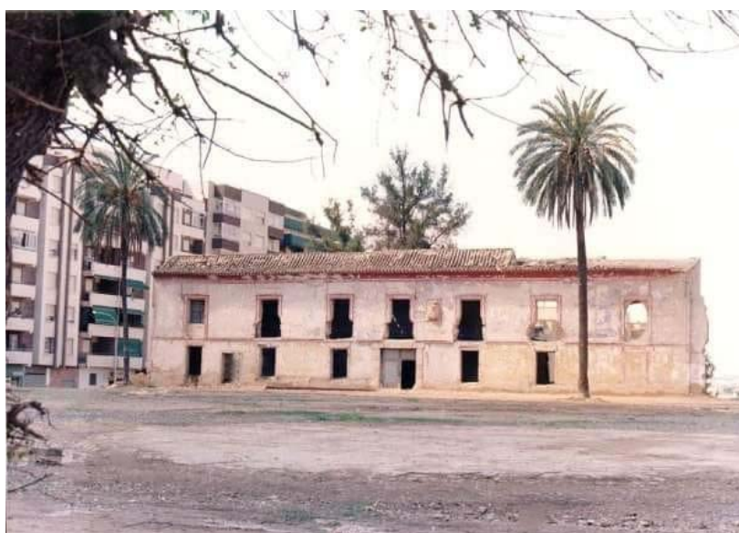
Figura 31. Casa Compañía en fechas previas a su demolición en 1981. Fuente: Molina de Segura historia fotográfica.
