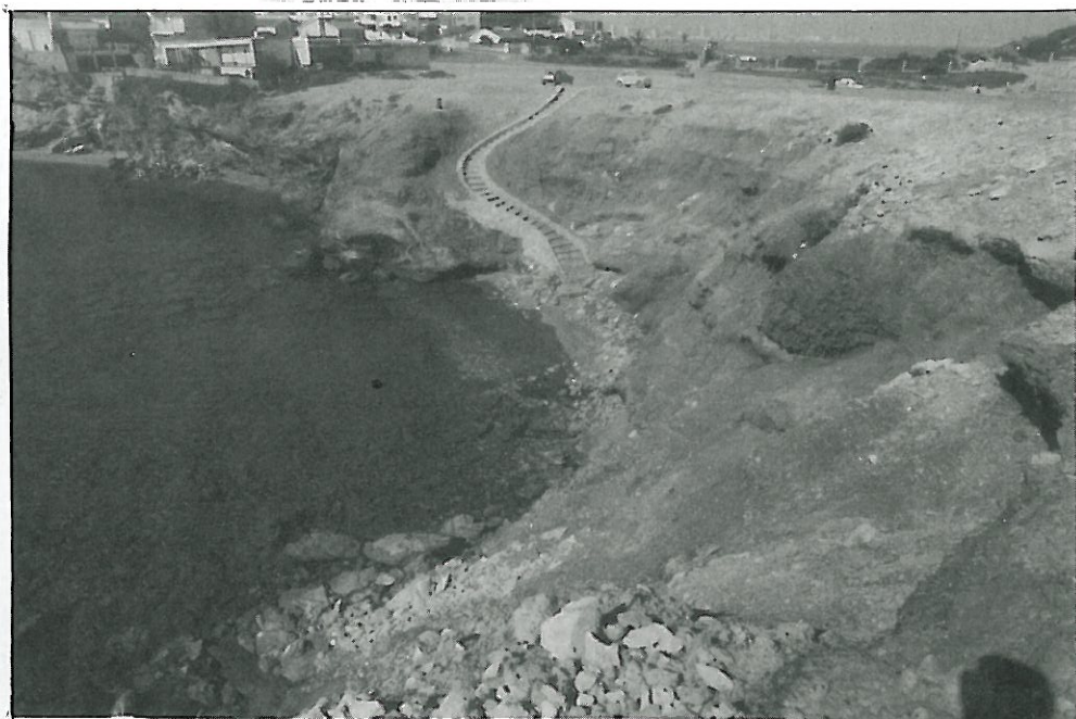
Estado de la misma cala actualmente.
