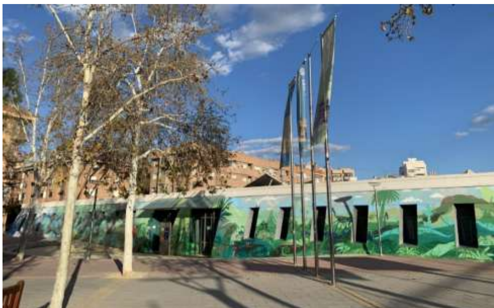
Figura 32. Fachada del Museo de la Ciencia y el Agua. Fuente: elaboración propia.
