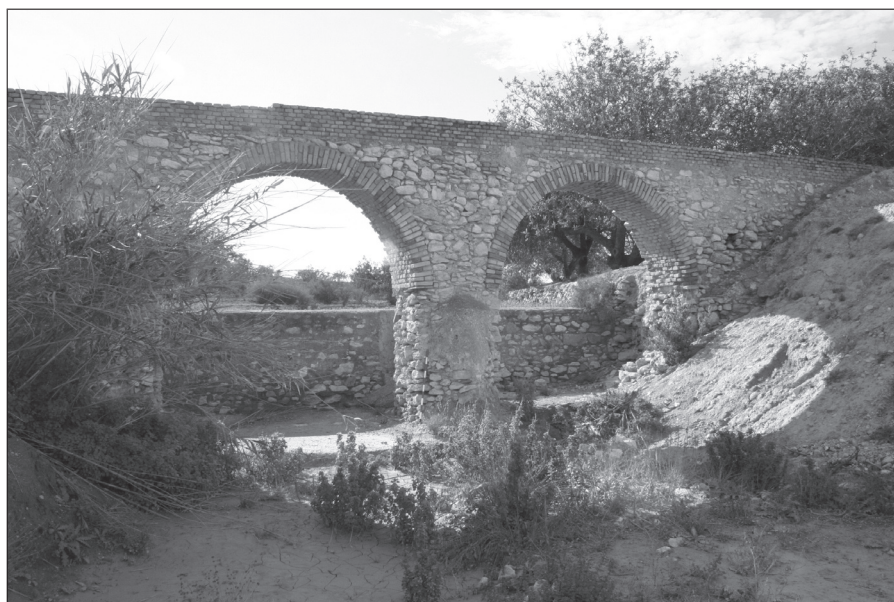
FOTO 17: Acueducto en la Rambla del Fraile. Cartagena.
