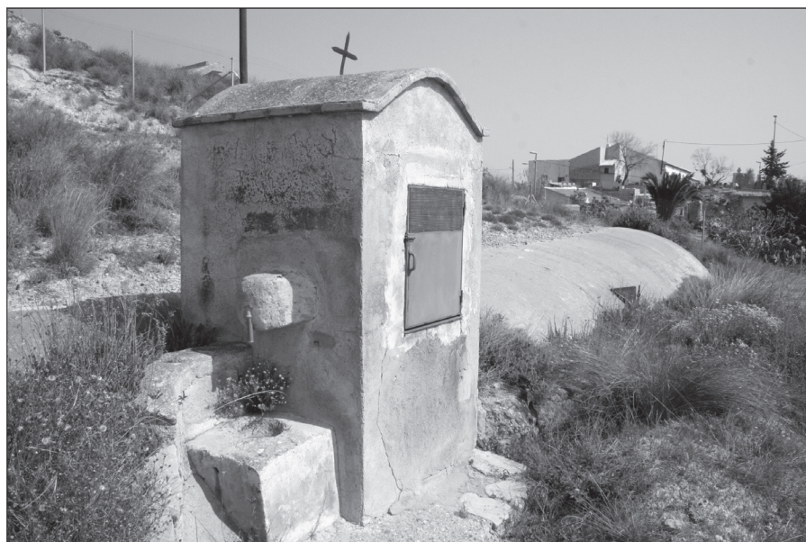
FOTO 9: Cantarero del aljibe del sifón. La Murta (Corvera).
