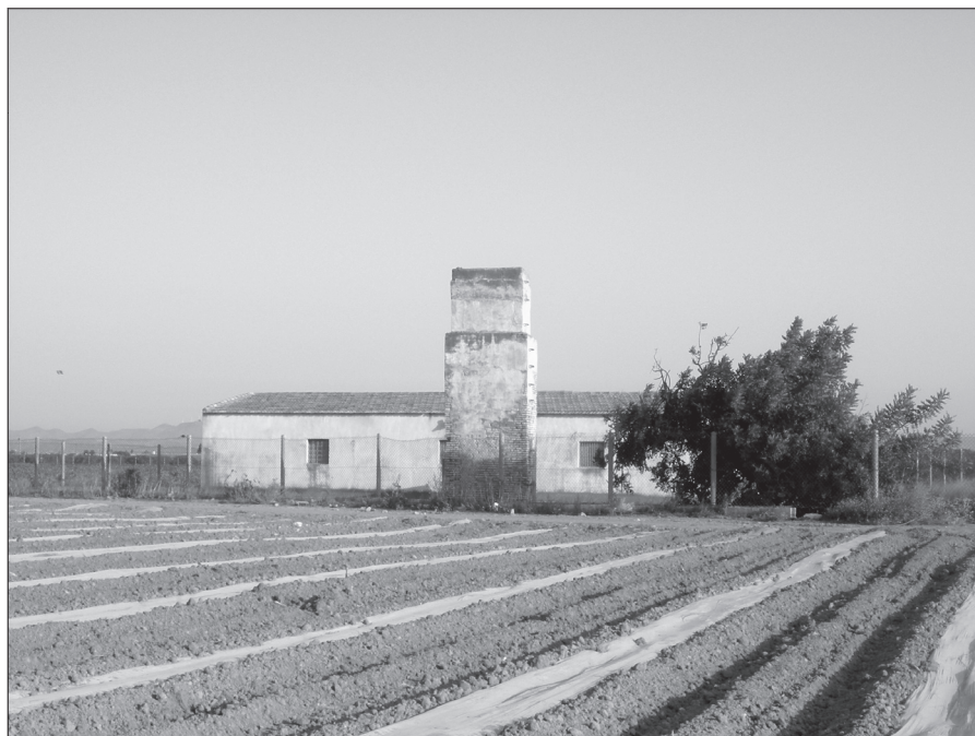
FOTO 16: Lumbrera. Chac3n (Torre Pacheco).
