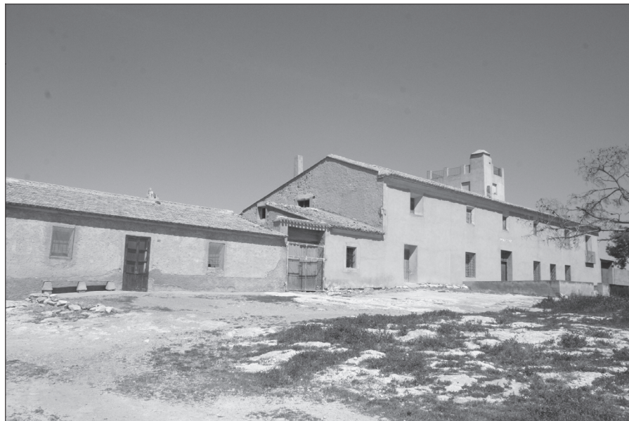
FOTO 21: Casa principal. Finca La Torrica (Valladolises).
